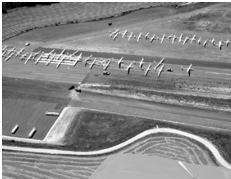
Imagen de las instalaciones del aeródromo de Santa Cilia. D.A.
